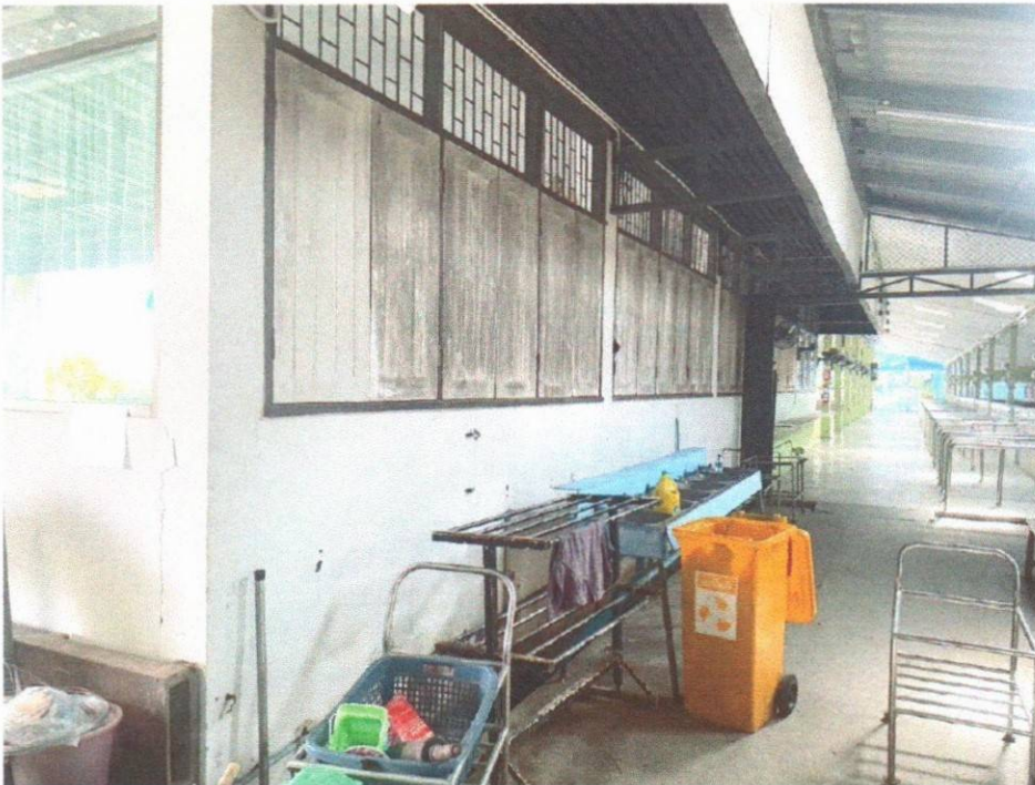
ภาพถ่ายด้านซ้าย (อาคารคหกรรม แบบ ค.ส.ล. ๑ ชั้น)
